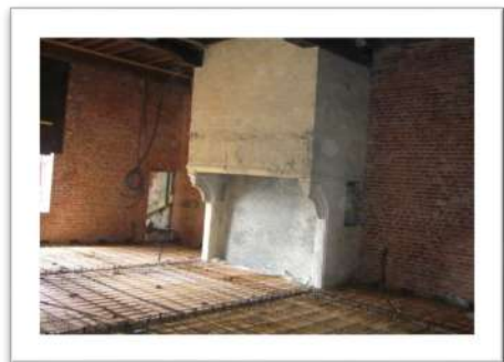
Vue de la salle 7 pendant le chantier de réhabilitation, 2008-2010
