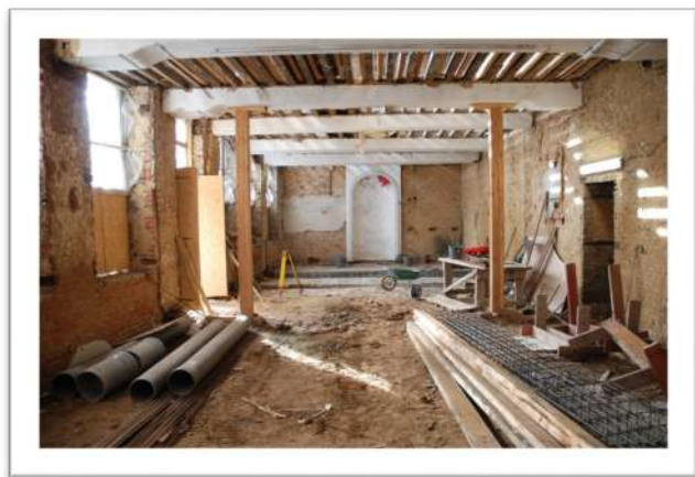
Chantier de réhabilitation entre 2008 et 2010
